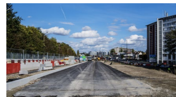
Une voirie partagée et sécurisée (avenue du Général de Gaulle, Antony)
