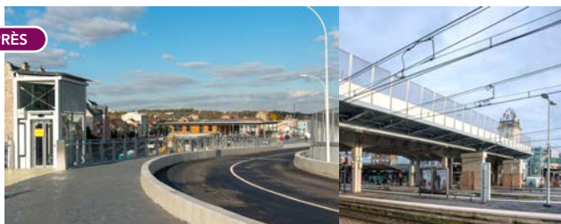
Le pôle d'échanges de Juvisy-sur-Orge, le pont routier et la passerelle des mobilités douces en cours d'achèvement
