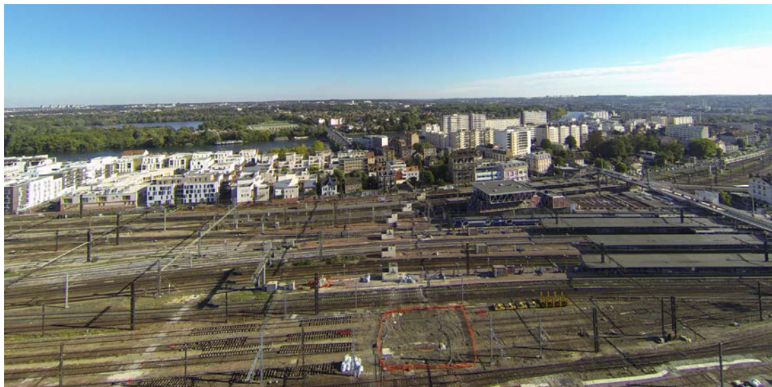
PHOTOS : SNCF GARES & CONNEXIONS - AREP / PHOTOGRAPHE MATHIEU LEE VIGNEAU
