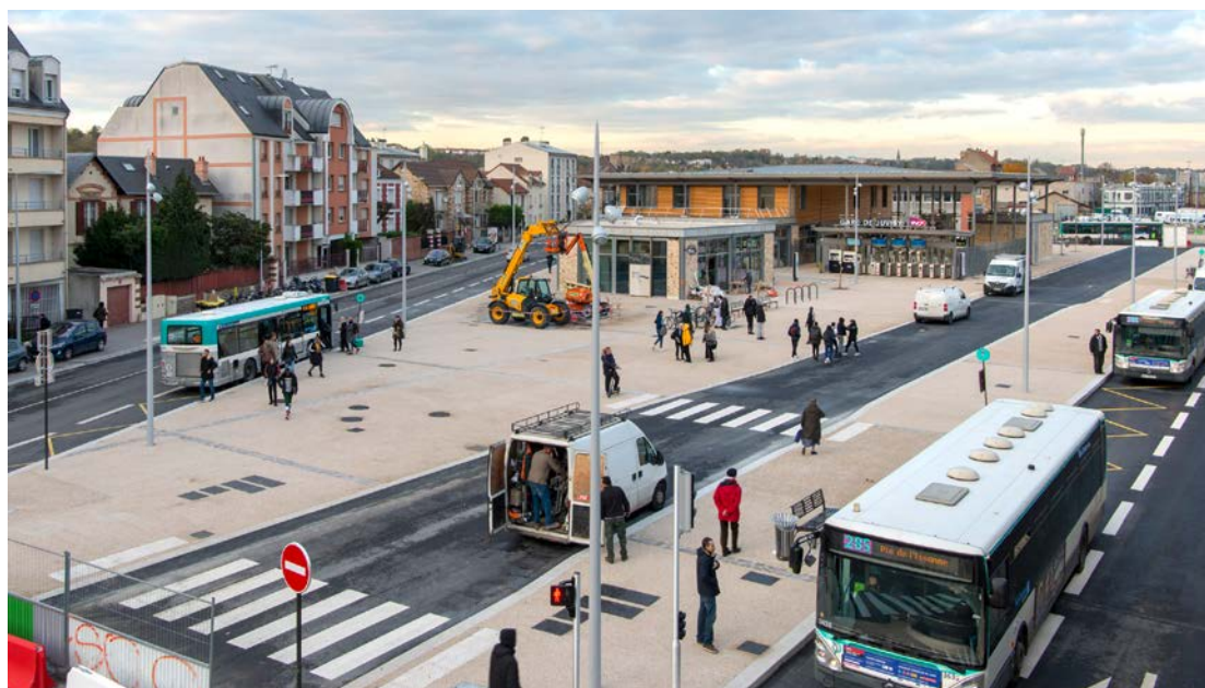
Le pôle d'échanges de Juvisy-sur-Orge, la gare routière et l'accès mairie en cours d'achèvement (nov.2019)
