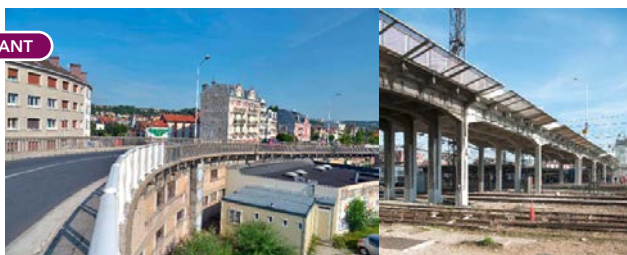
Le pôle d'échanges de Juvisy avant travaux, vue du pont routier vue ouest-est (août 2014)
