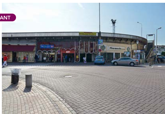
Le pôle d'échanges de Juvisy avant travaux, l'accès Mairie sous la rampe du Conseil Général (août 2014)
