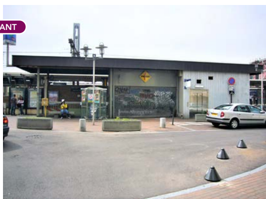
Gare de Juvisy, accès Seine avant réhabilitation (oct. 2006)
