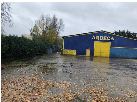
Vue du hangar ARDECA
