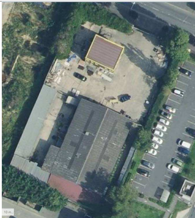
PHOTOGRAPHIE AERIENNE DE LA PARCELLE 104 ET DE SES BATIMENTS (GEOPORTAIL)
