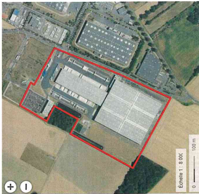
Figure 2 : Vue aérienne de la plateforme logistique
