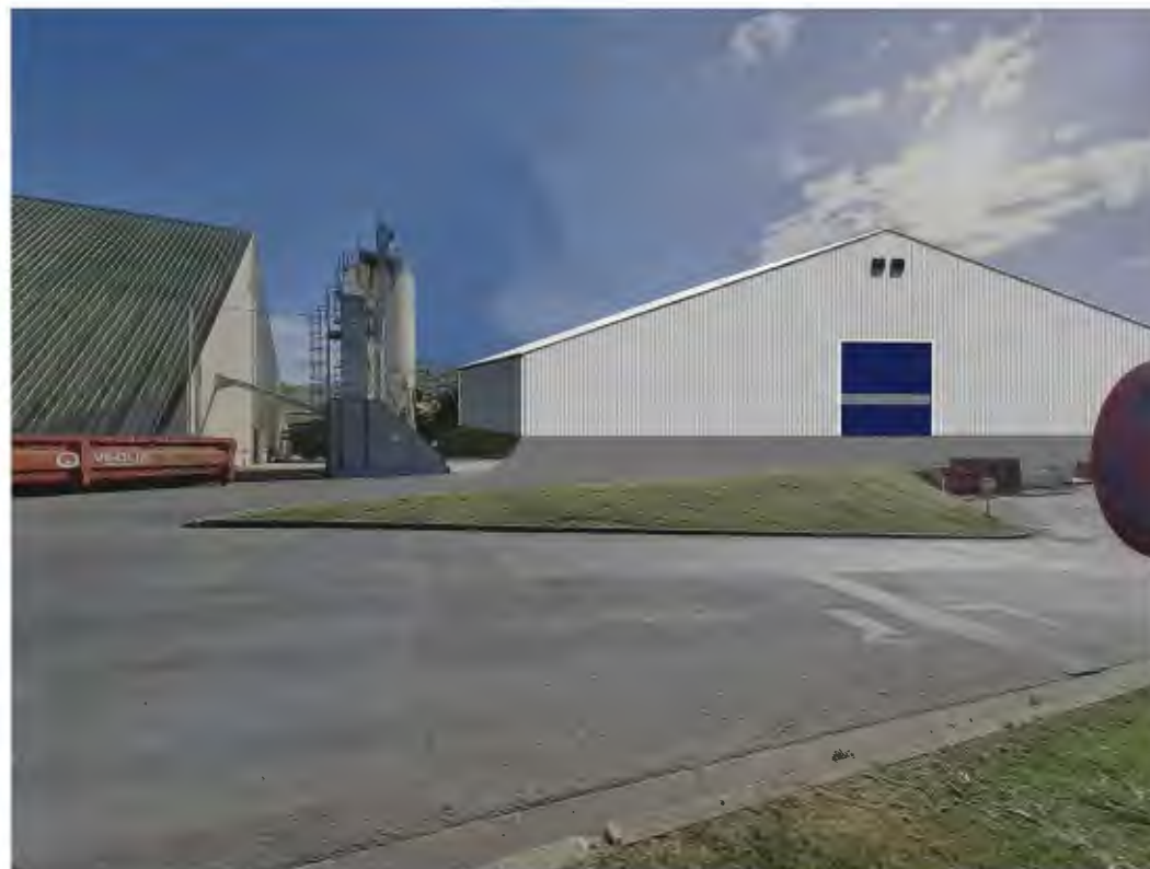
APRES TRAVAUX Vue 1
