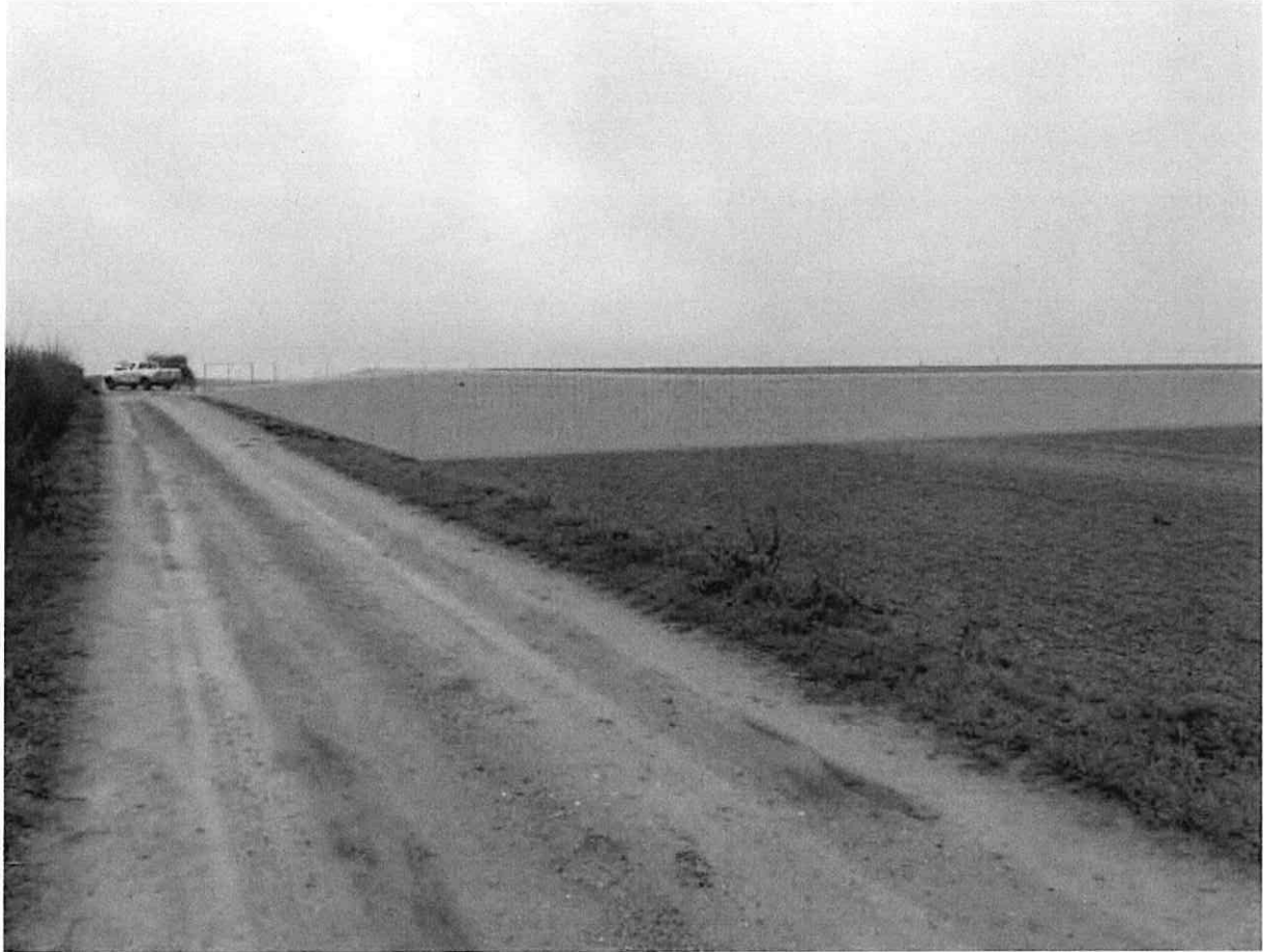
Lagune de Puisieux - Vue 2 après travaux
