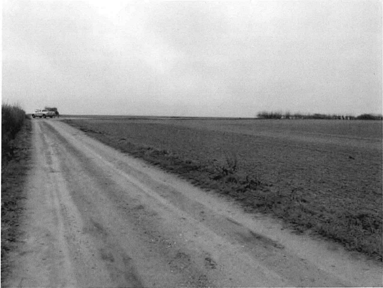
Lagune de Puisieux - Vue 2 avant travaux
