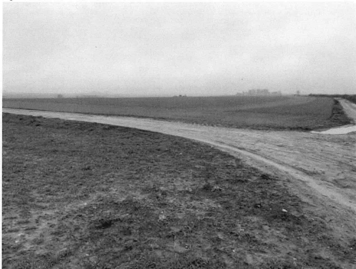
Lagune de Puisieux - Vue 1 avant travaux
