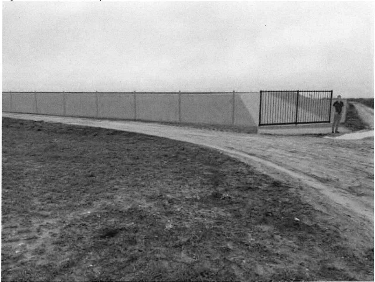
Lagune de Puisieux - Vue 1 après travaux
