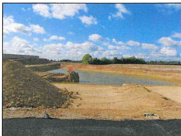
Bassin d'infiltration en construction Source : ARTIFEEEX 2021
