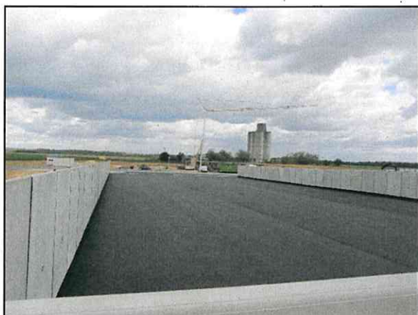
Silos en construction Source : ARTIFEEEX 2021
