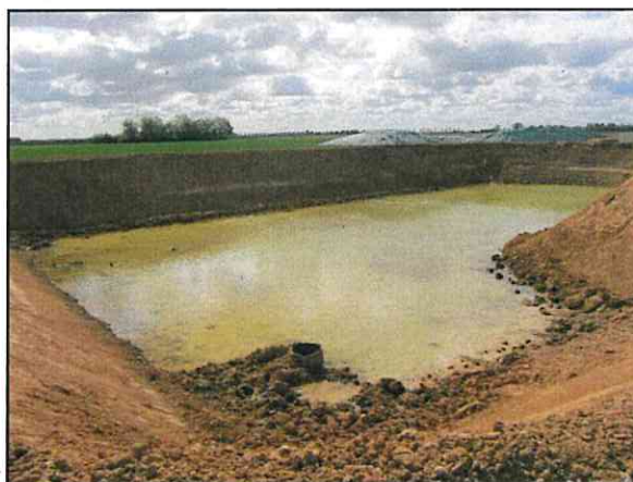
Lagune de stockage du digestat brut en construction Source : ARTIFEEEX 2021
