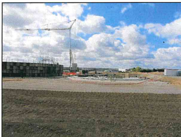
Cuves en construction Source : ARTIFEEEX 2021
