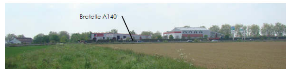
Photo 3 : Limite Est du périmètre et bretelle d'autoroute A140 depuis l'aqueduc de la Dhuis.
