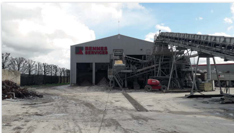
3- Tapis d'alimentation et bâtiment de la nouvelle ligne de tri.
