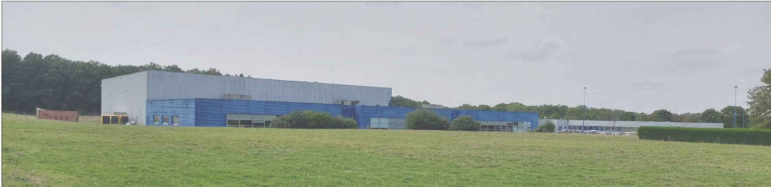
PC7 -3 Vue depuis l'extrémité Nord-Est du terrain
