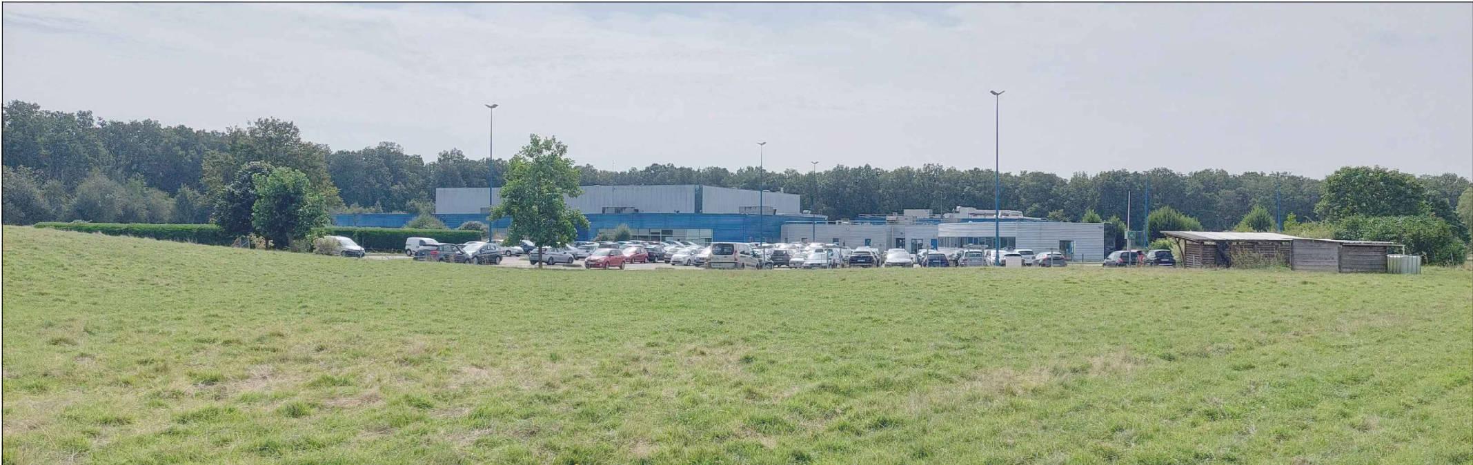
PC8-2 Vue depuis l'angle Nord-Ouest
