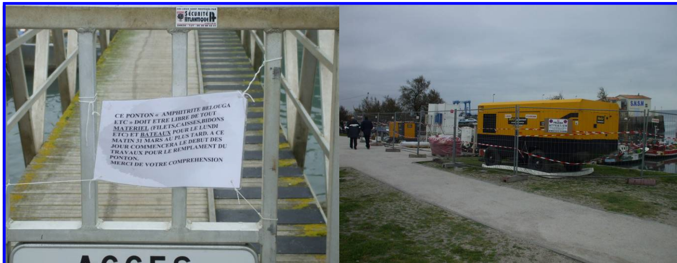
Exemples d'information et de limitation de la zone relative au chantier.
