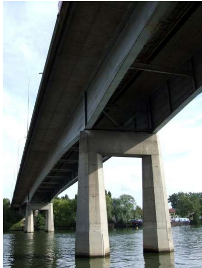
Photo 3 : piles du pont route (© Vincent Le Quéré, août 2004, Licence Structurae)
