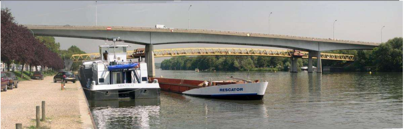
Photo 2 : pont route (© Vincent Le Quéré, août 2004, Licence Structurae)
