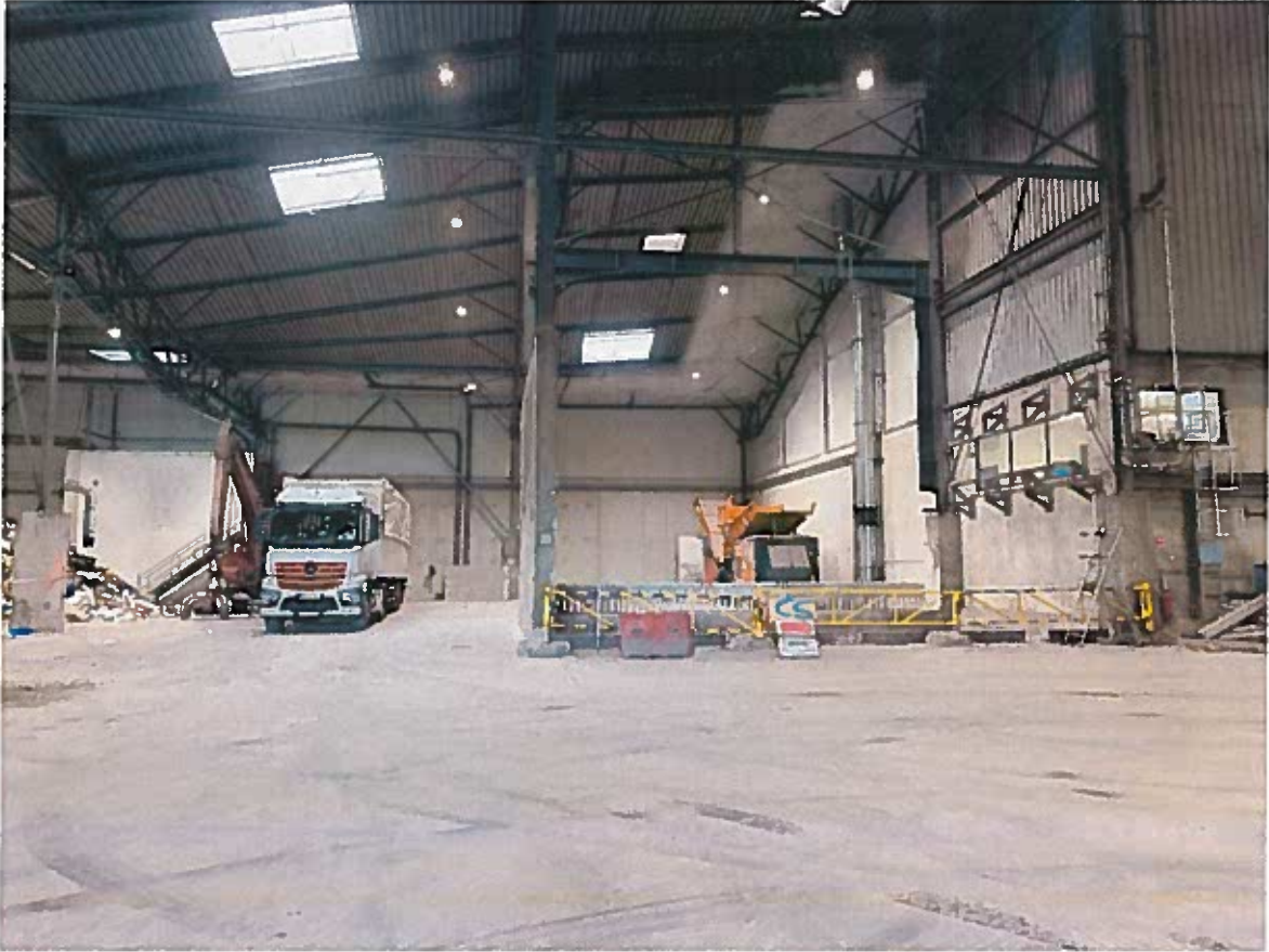
Figure 3 : Vue n°2, dans l'environnement proche (zone encombrants, janvier 2020)
