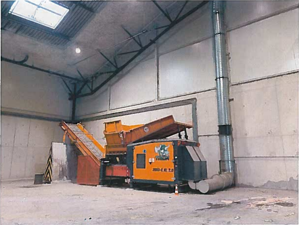
Figure 4 : Vue du site n°3, dans l'environnement proche (broyeur encombrants, janvier 2020)
