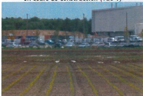
Figure 64 : Vue du site vers le bâtiment BNP en cours de construction (vue 1)
