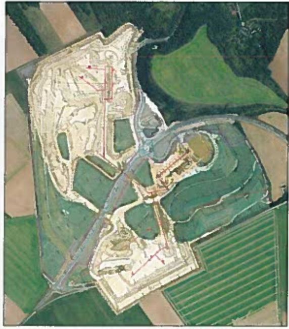
PHOTOGRAPHIE AÉRIENNE DE LA CARRIÈRE DE BONNEVAULT ET SUPERPOSITION DU PLAN DES INFRASTRUCTURES
