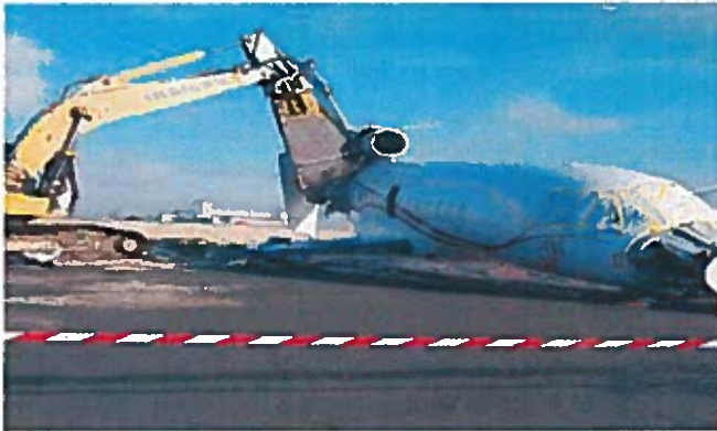
Pelle mécanique type 944 Liebherr lors de travaux de découpe
