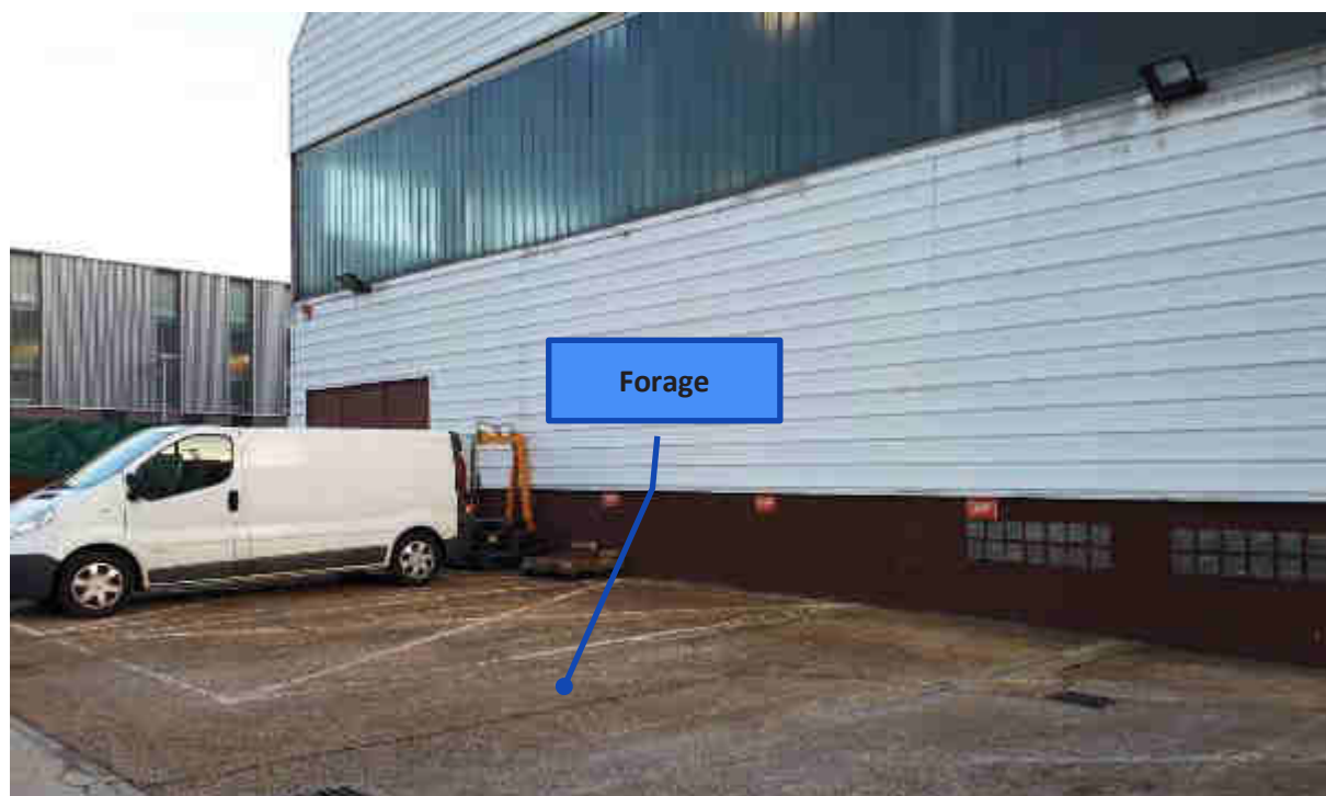
Figure 3 : Implantation forage – vue 1 (décembre 2019)
