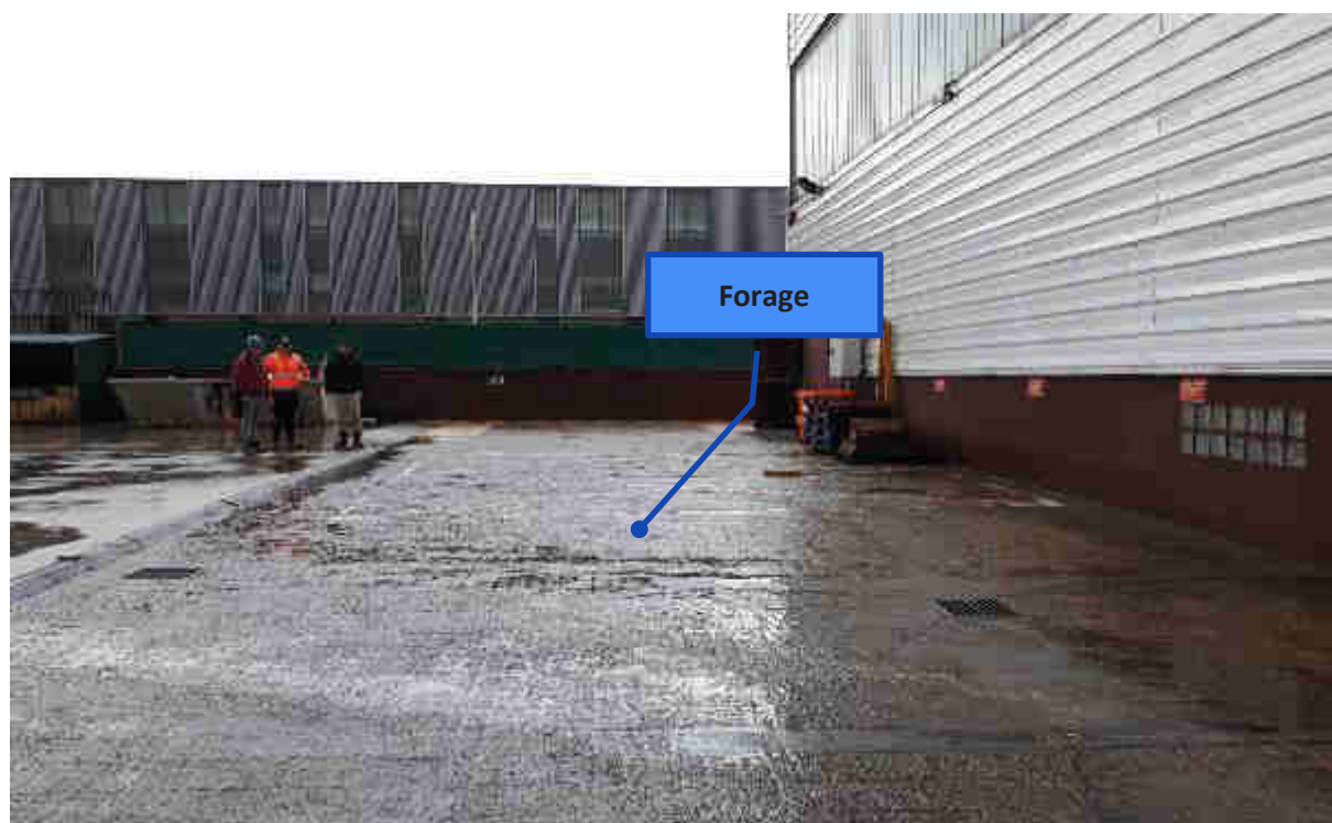
Figure 4 : Implantation forage – vue 2 (janvier 2020)
