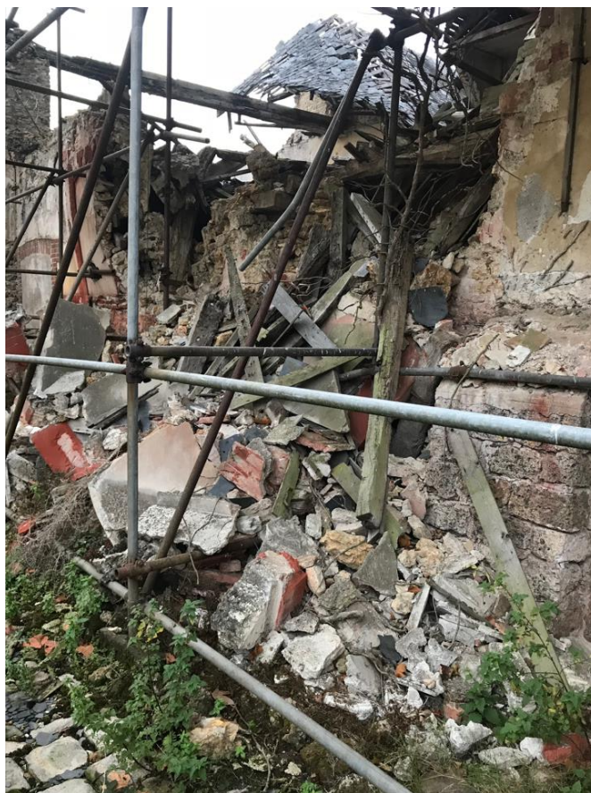
Effondrement du pavillon angle Nord-Ouest en 2013 malgré la protection du parapluie
