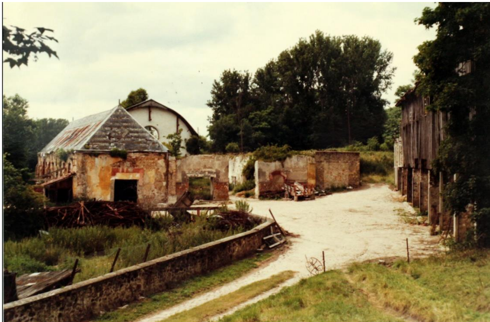
Bâtiment de l'Orangerie en 1982
