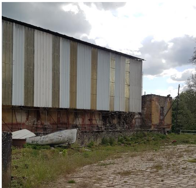
Mise en place d'un « parapluie » à la demande de la DRAC en 2010 afin de protéger le bâtiment des infiltrations d'eau.
