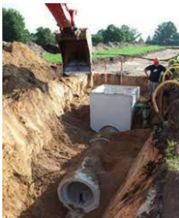
**Pose de tuyaux en béton –
