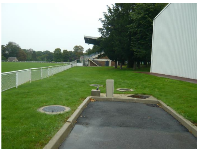
Emplacement du bassin enterré de récupération des eaux de pluie du tennis de Limeil-Brévannes : au premier plan : la zone d'accès pour le camion-citerne ; au second plan à droite : le tennis couvert.
