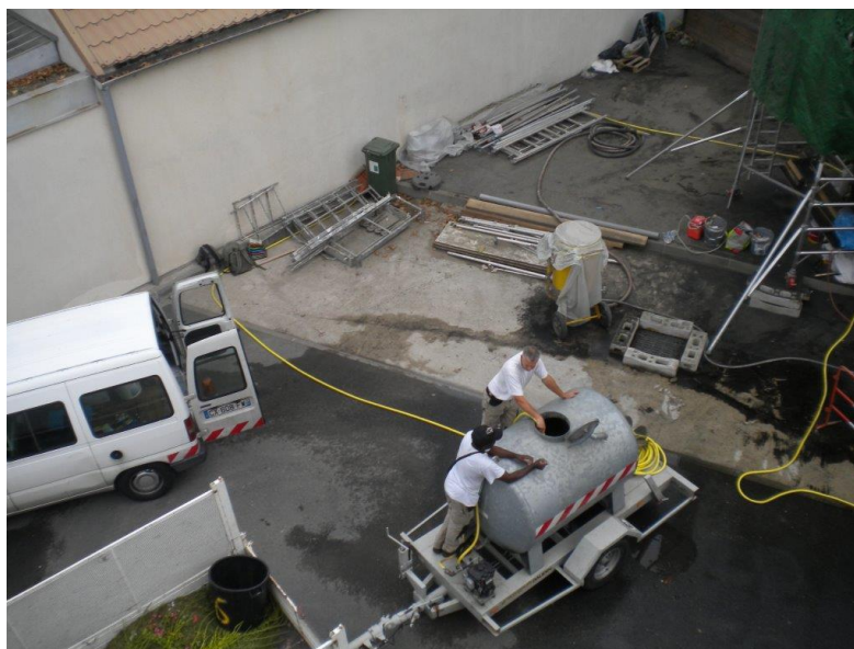
Remplissage des camions par de l'eau non potable aux services techniques de Bonneuil-sur-Marne
