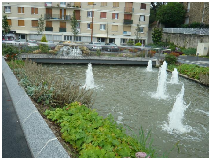
Bassin d'agrément utilisant l'eau pluviale à Orly, place de la gare. Le bassin de rétention et le bassin d'agrément fonctionnent en circuit fermé.
