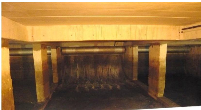
Nettoyage du bassin de Sucy par les eaux pluviales traitées (Département du Val-de-Marne)
