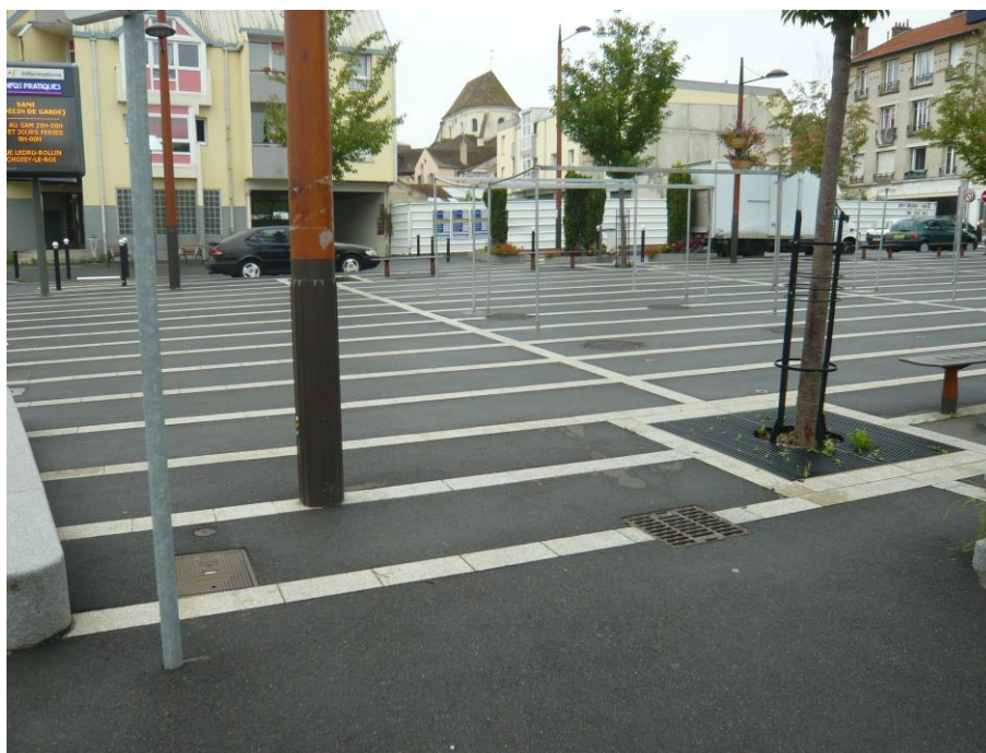
Cuves enterrées place du marché, à Orly, récupérant les eaux de pluie du gymnase. L'eau est ensuite utilisée pour l'arrosage.
