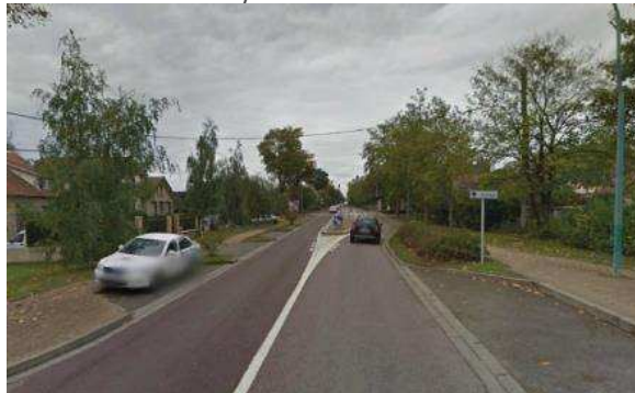
La RD190 vers l'ouest de l'entrée du site d'EMTA
