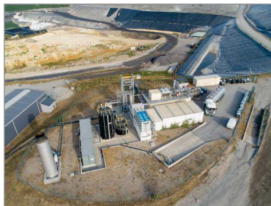
Figure 4 : Plateforme de cogénération et de traitement des lixiviats de Déchets Non Dangereux (2019)
