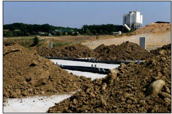
Figure 18 : Mise en biopile
