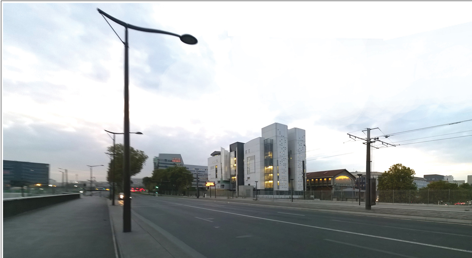
VUE DEPUIS PONT NATIONAL
