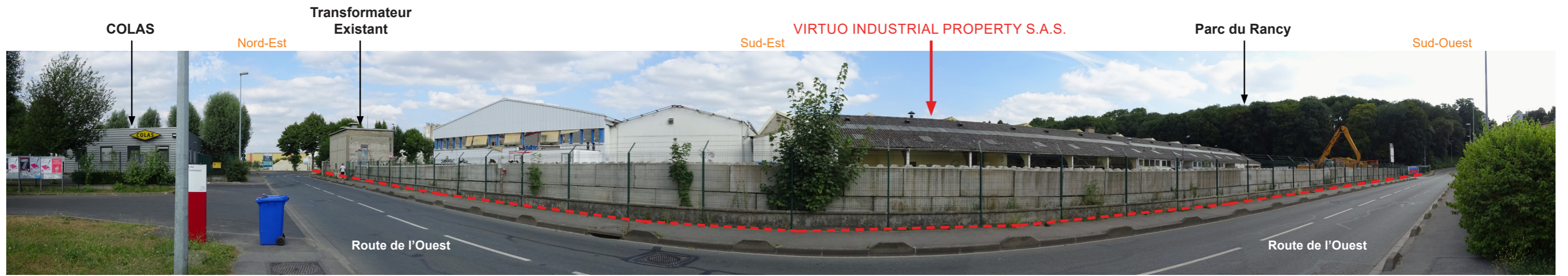
10 - VUE DEPUIS LA ROUTE DE L'OUEST, VERS LE SUD-EST.
