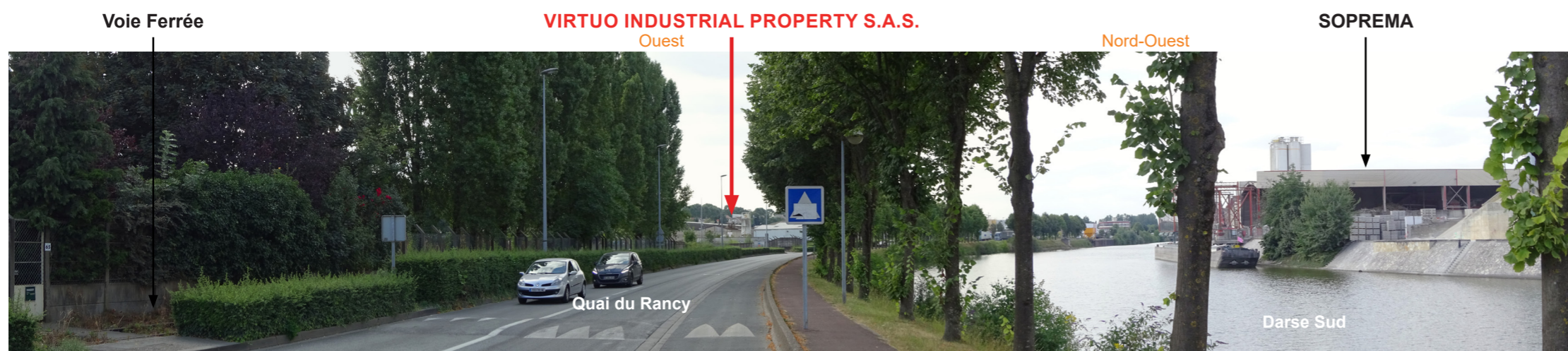
2 - VUE DEPUIS LE QUAI DU RANCY, VERS LE NORD-OUEST.
