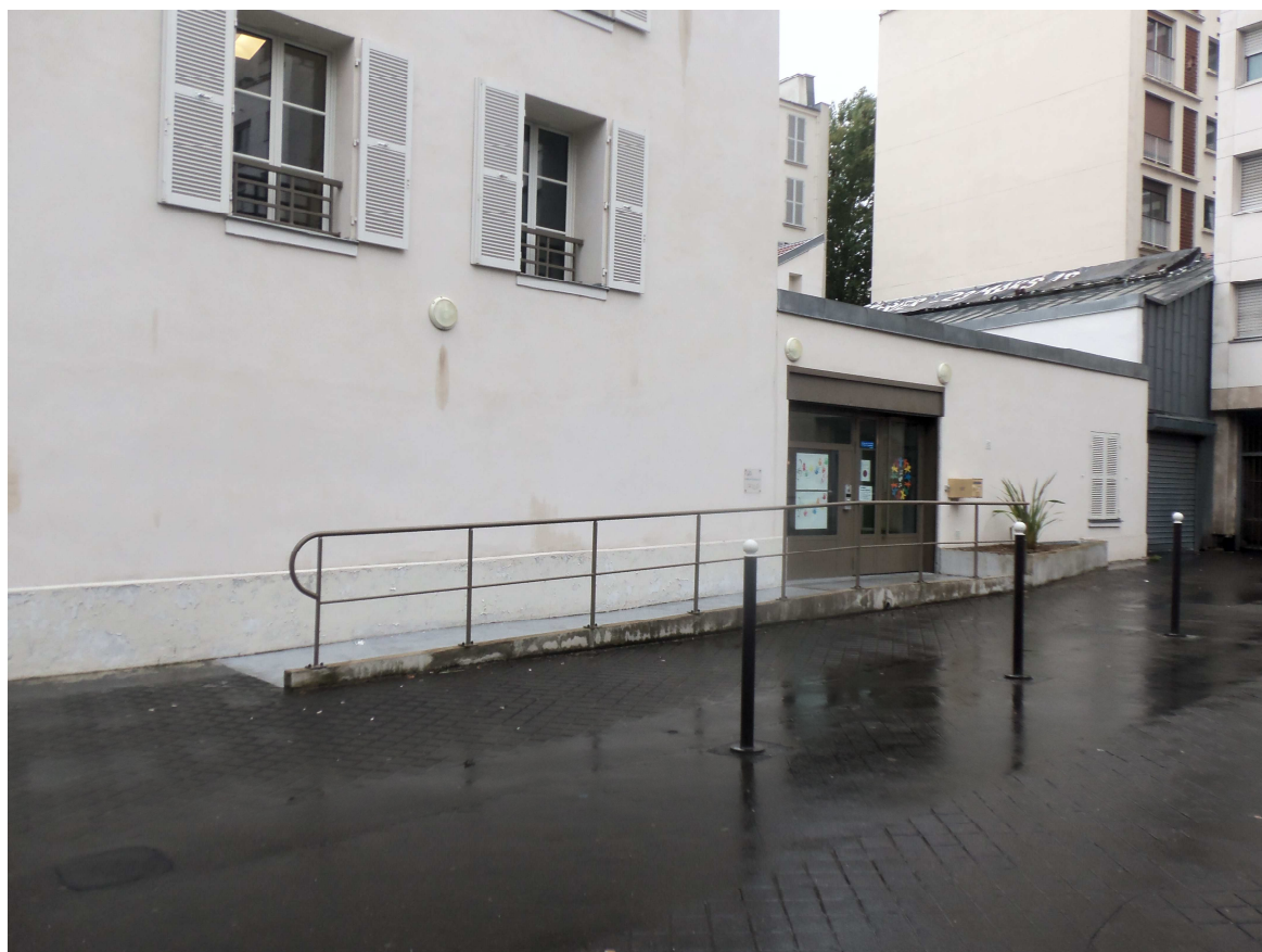
17_Crèche rue Adolphe Mille
