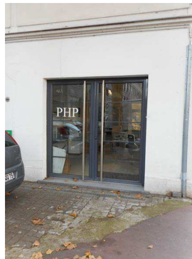
36- Vue bât 13 depuis rue Maurice Arnoux
