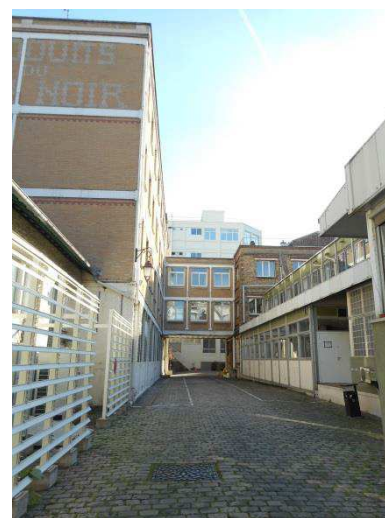
21- Vue du site (bâtiment a et b, nord-est)
