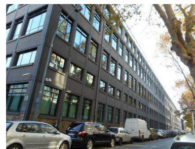
33- Vue bât 1 depuis rue Maurice Arnoux
