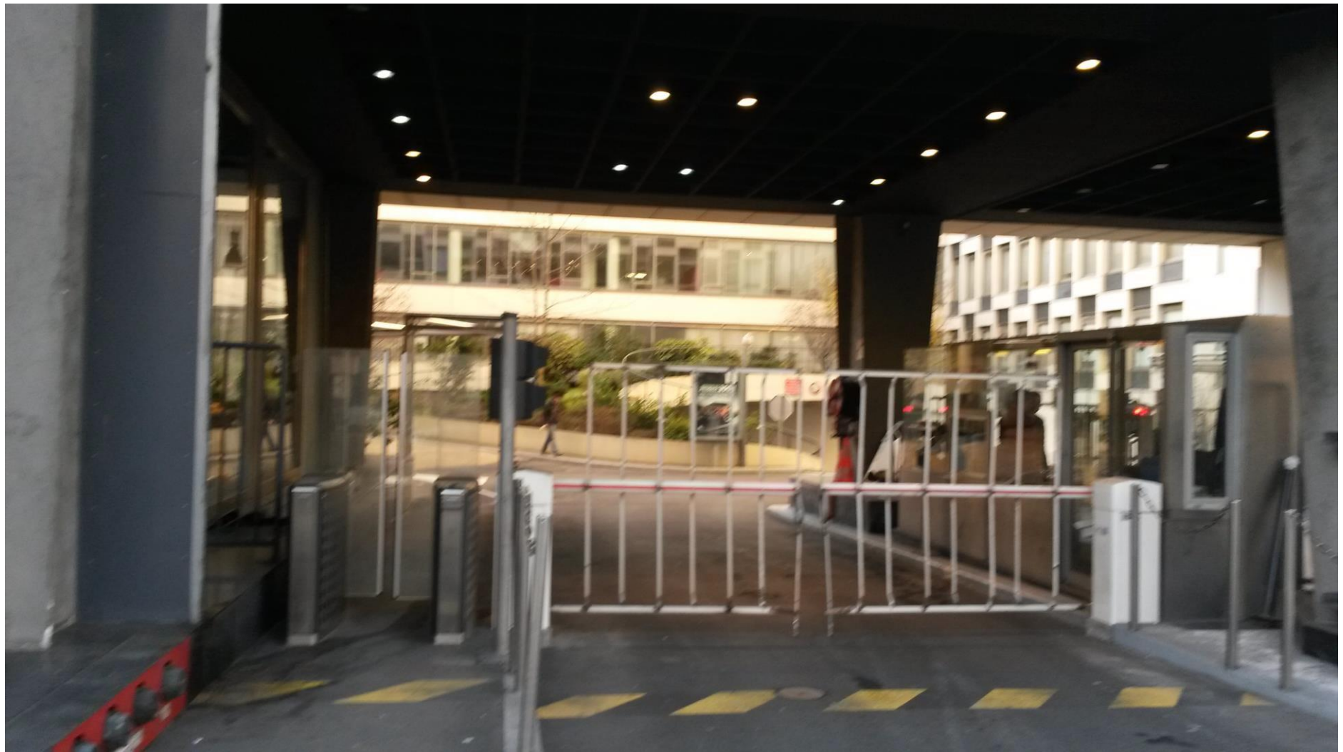
Photo n°2 : Passage sous bâti actuel vers cours intérieur-prise le 14 décembre 2016
