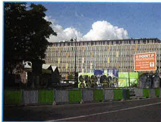
▲ Vue depuis la rue de la Gare, vers le nord
