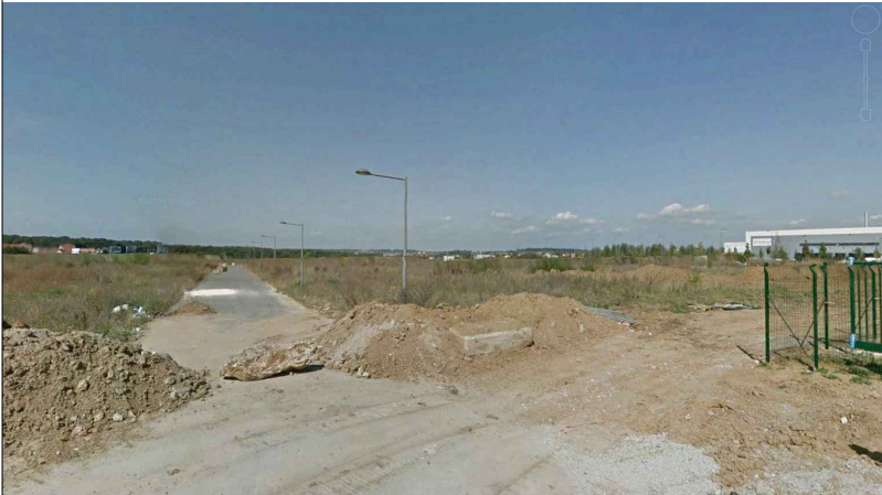
PHOTO 2 : vue depuis l'accès au site, rue de la Découverte, à l'Est
