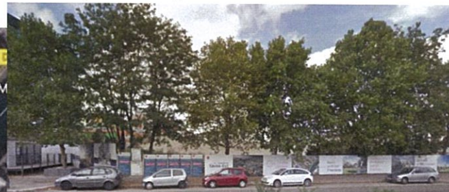
Vue du quai d'Aulagnier :
