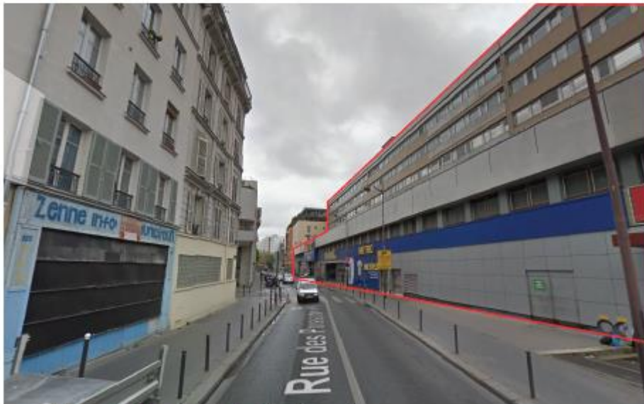
3 vue de la rue des poissonniers depuis le local Shurgard
