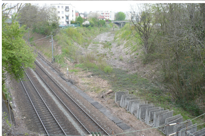
G - Les voies ferrées et l'ancienne emprise à l'ouest
