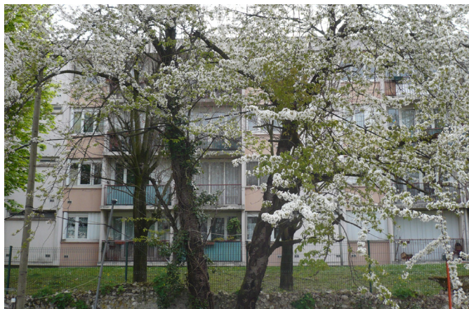
E - Depuis le site du projet vers le bâti à l'est
