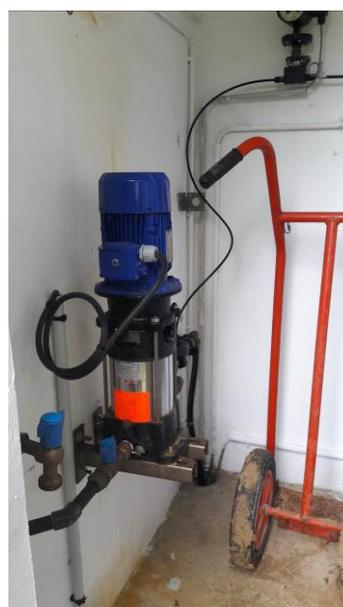
Photographie 6 : Injection de chlore dans le forage du Réveillon
