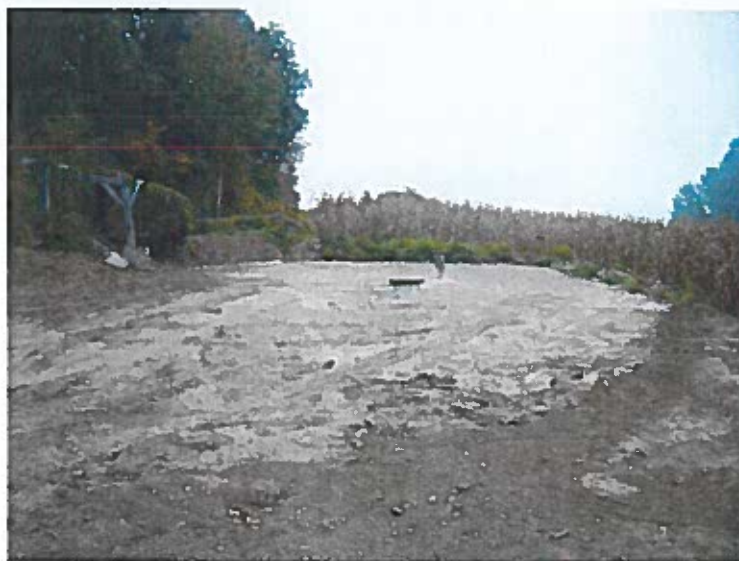
Photo 1 : forage (octobre 2016) en direction de l'Est
