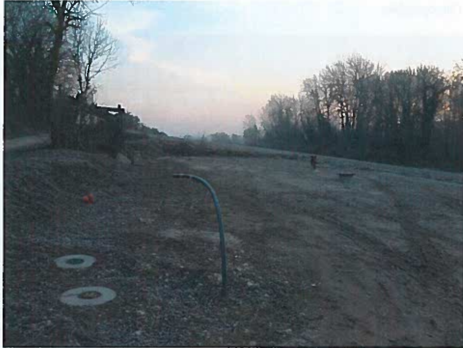
Photo 1 : forage (janvier 2017) en direction de l'Est
