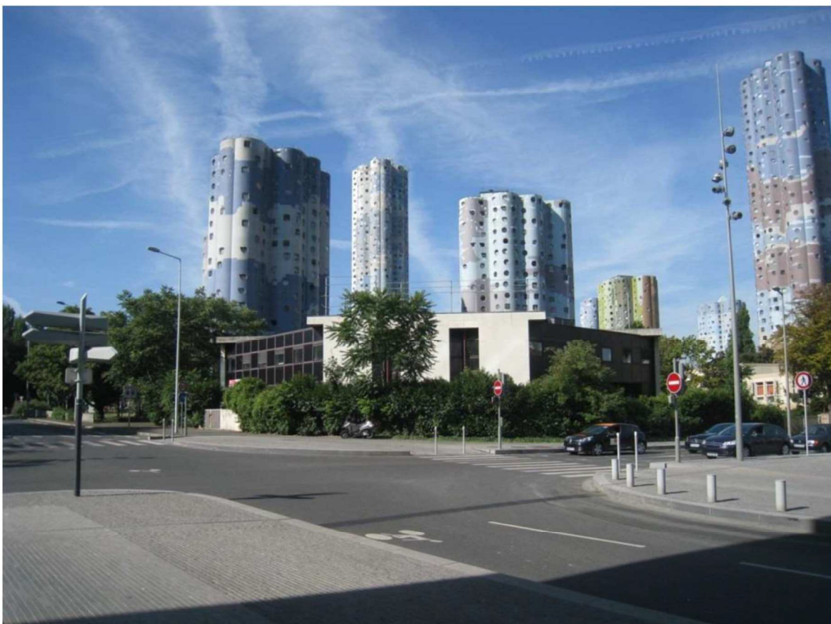
Photo 6 : Bâtiment existant au carrefour entre l'avenue Pablo Picasso et le boulevard de Pesaro
