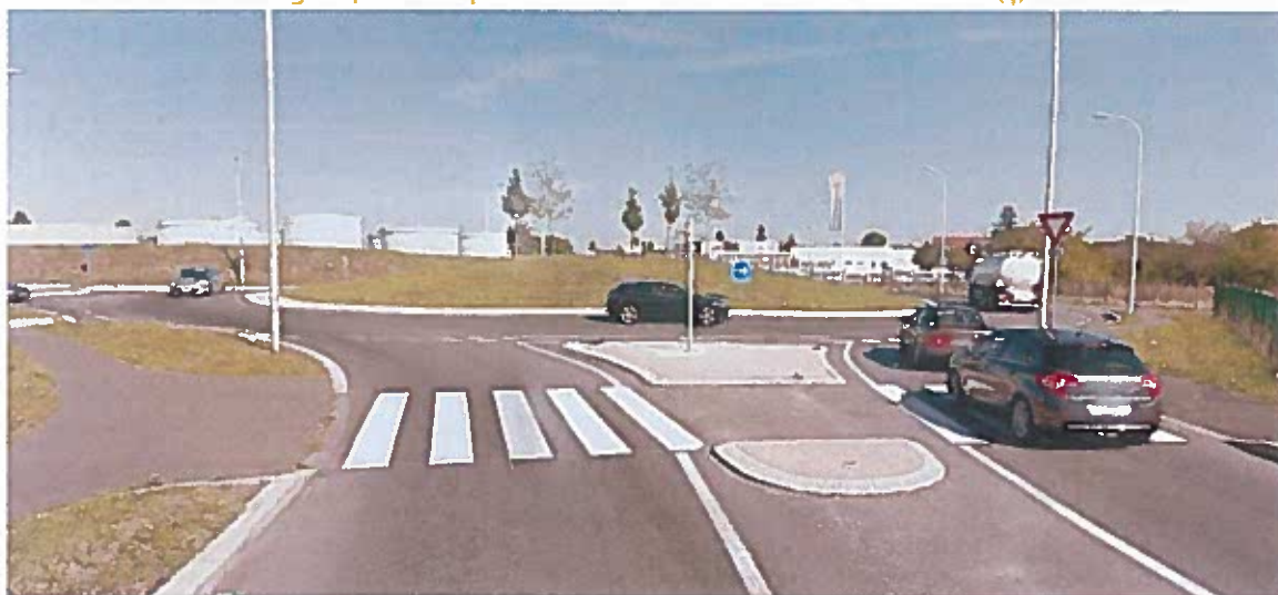
Figure 4 : Le rond-point au niveau de la RD118 à l'Ouest de la zone (4)
