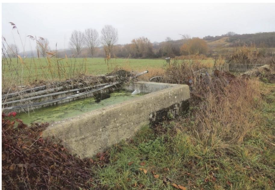
**Photographie 10 : Récupérateur d'eaux de ruissellement le long du chemin d'exploitation traversant le site**
