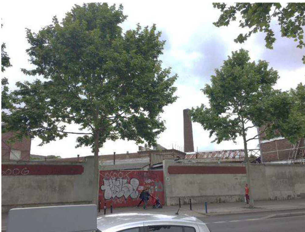
Photographie 3 : le site (accès voiture) depuis Avenue de la République
