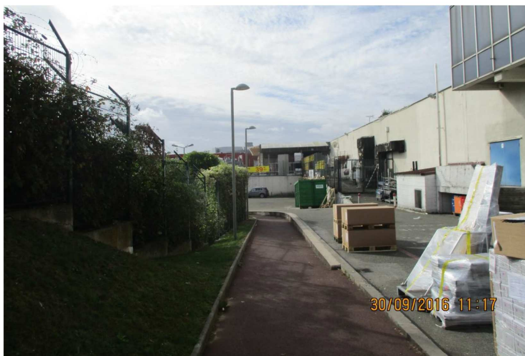
Photographie 12 : entre l'existant (droite) et zone d'extension (gauche)
