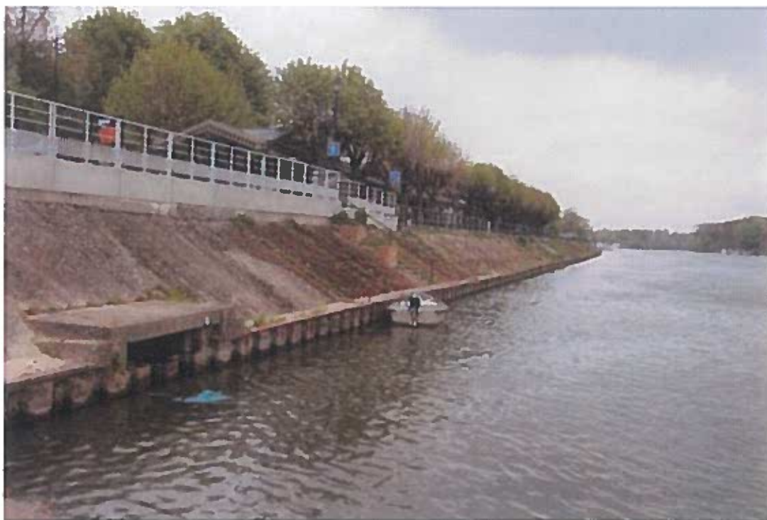
Vue 2 : Perré béton devant la promenade amont.
