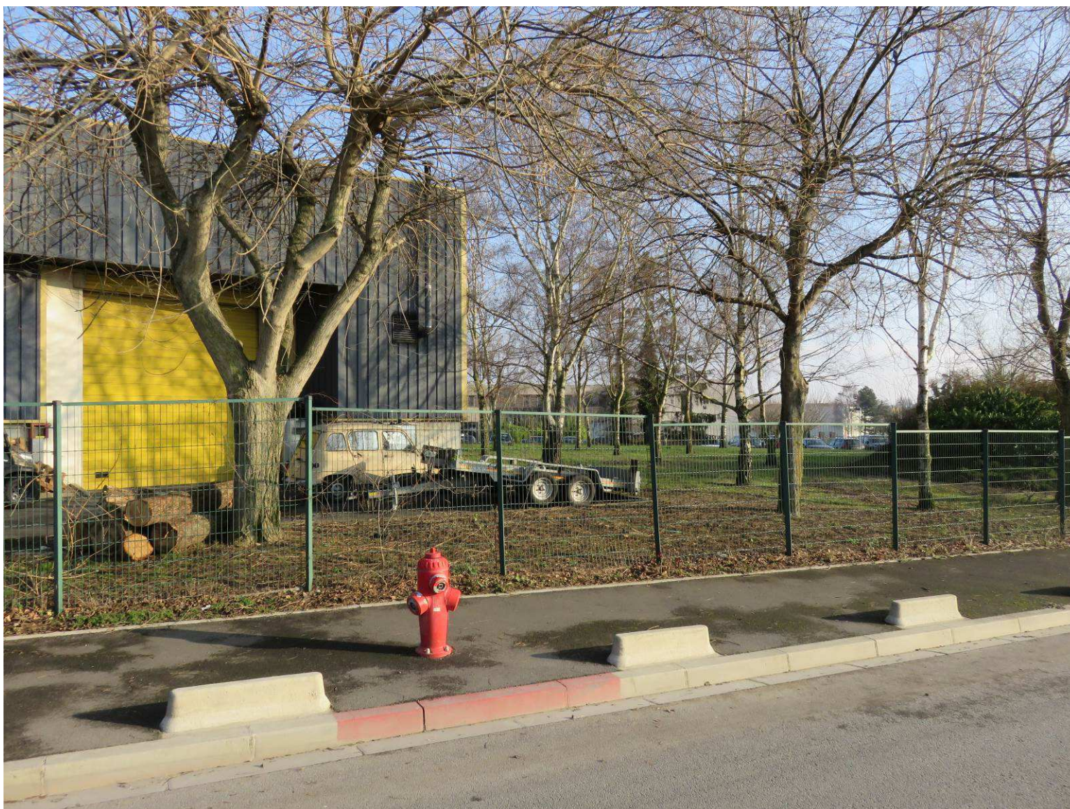
Figure 2 : Photo n°1, zone projet d'extension du bâtiment F
