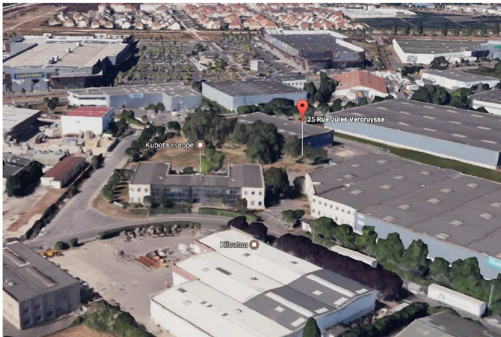
Figure 3 : Photo n°2, vue du site d'un point haut
