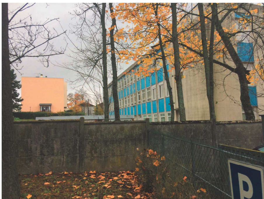
Photographie 14 : Vue du bâtiment à démolir vers le Nord (1)
