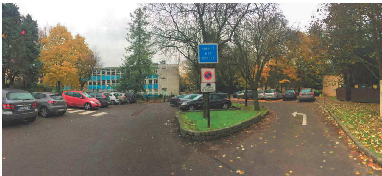
Photographie 4 : Vue du site étudié et du bâtiment à démolir
