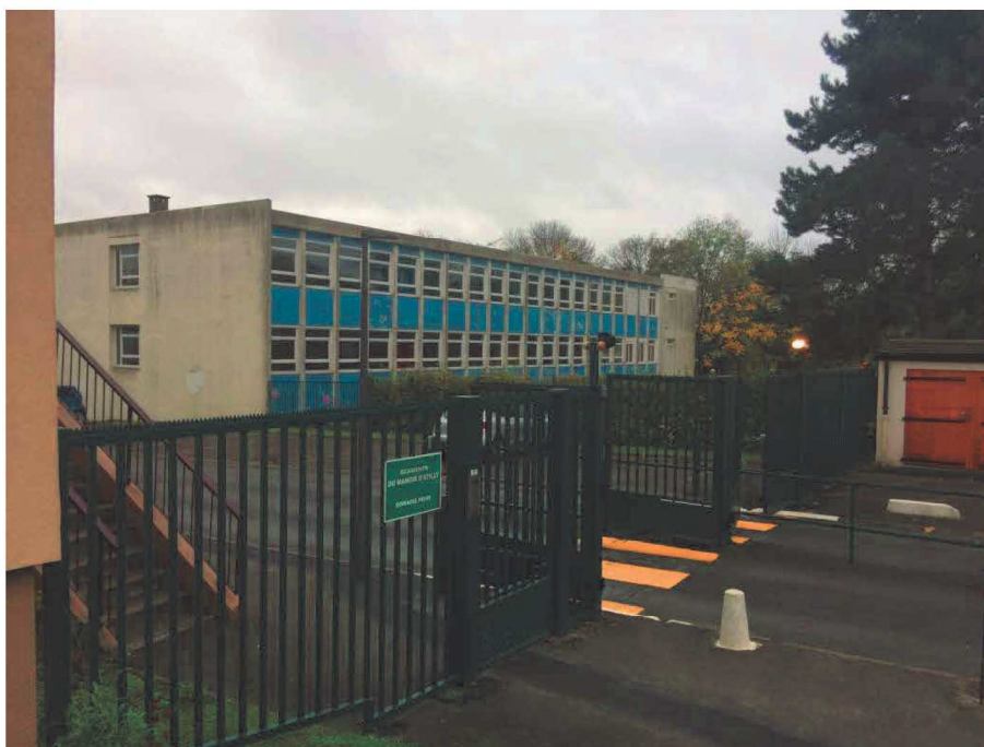
Photographie 10 : Vue du bâtiment à démolir sur le site étudié
