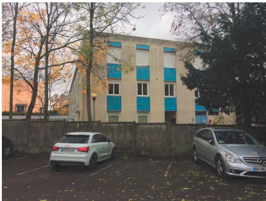
Photographie 15 : Vue du bâtiment à démolir vers le Nord (2)
