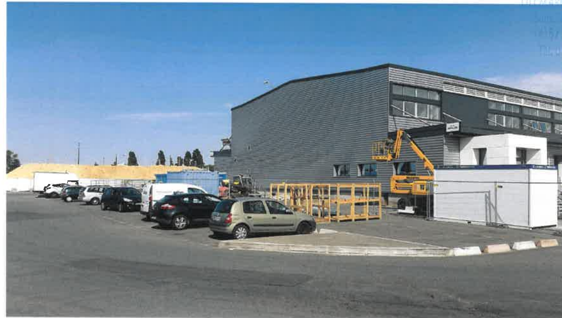
Vue existante sur parking et bâtiment I2 depuis rue des Glacières
