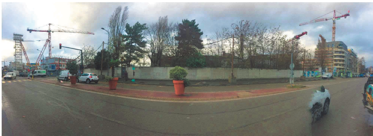
Photographie 7 : Vue de la limite sud-est du Lot B2 depuis le Boulevard Victor Hugo
