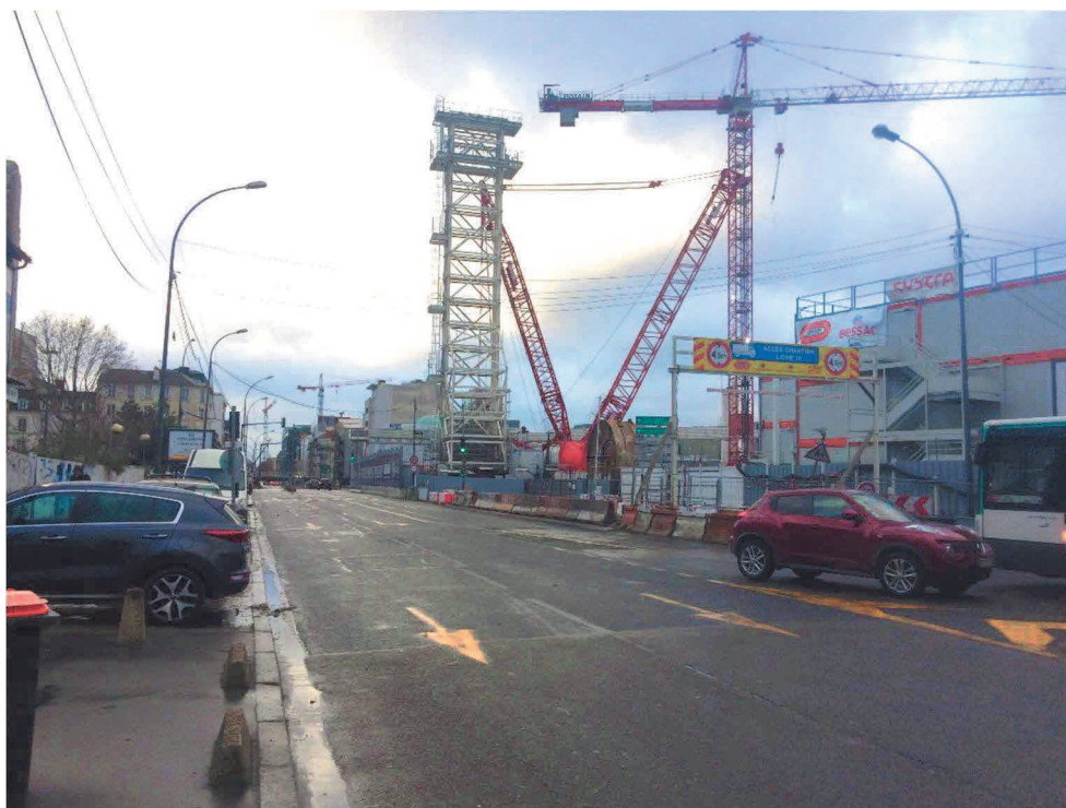
Photographie 9 : Zone de travaux du métro ligne 14 – Boulevard Victor Hugo
