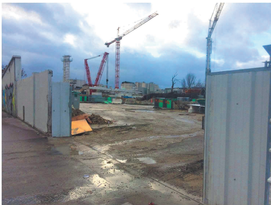
Photographie 15 : Vue du chantier fermé au public, rue Ardouin
