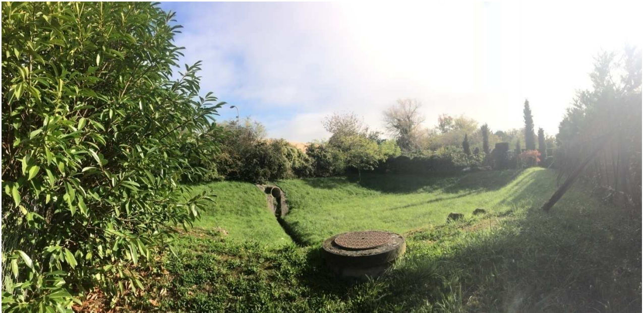
Photographie 4 : Bassin assurant le tamponnage des eaux de ruissellement du site
