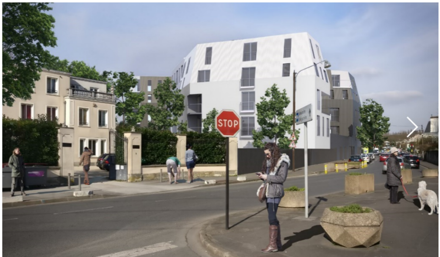
Vue 8 - projet – vue lointaine depuis la rue Abbe Pierre 02.2018
