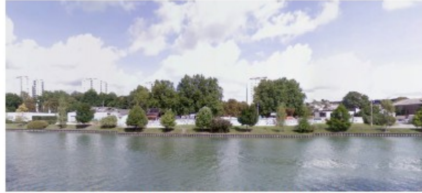
La deuxième séquence paysagère du quai nous montre le quartier industriel de Thorigny.
