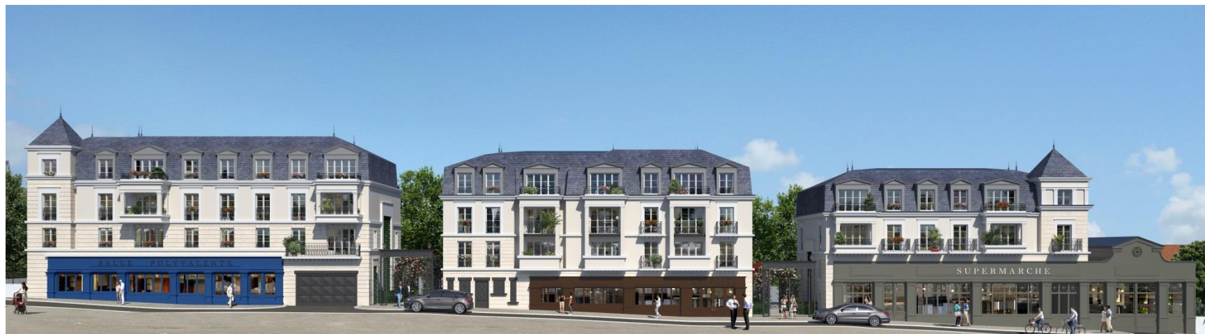
Figure 6 : façades îlot Roseiraie, côté rue Watel (Source : SCCV EMERIGE-L'HaÏ-les-Roses)
