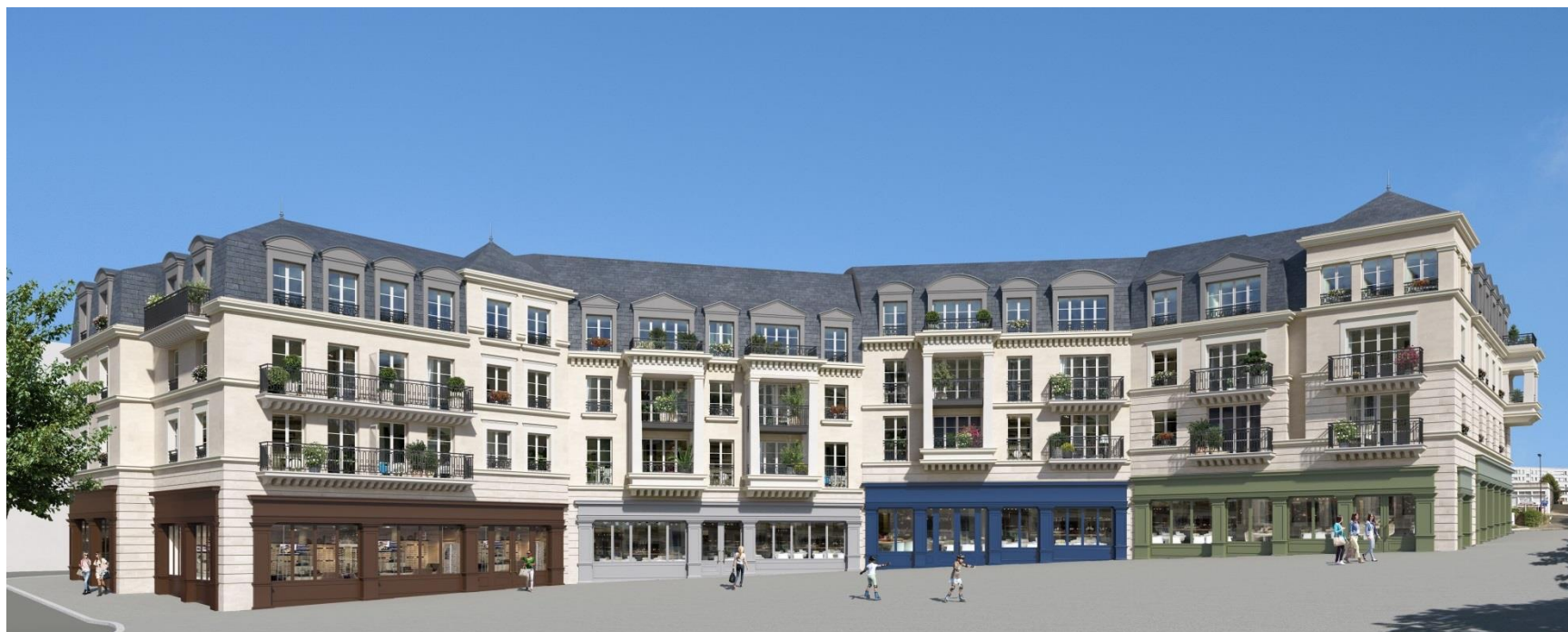
Figure 8 : façade îlot « Virgule », côté parvis (SCCV EMERIGE-L'HaÏ-les-Roses)
