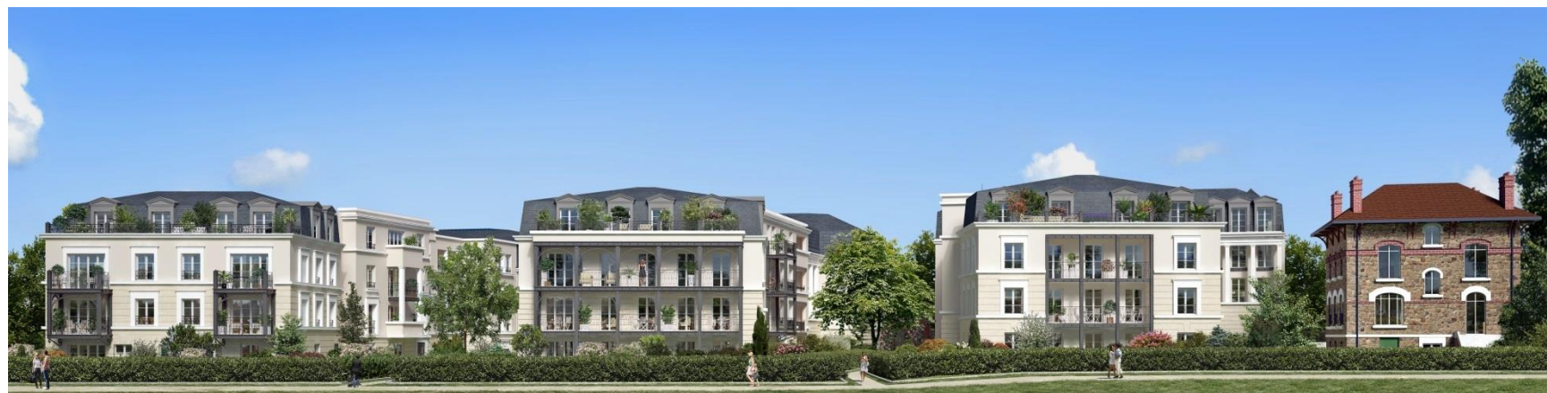
Figure 7 : façades îlot Roseiraie, côté Parc de la Roseiraie (Source : SCCV EMERIGE-L'HaÏ-les-Roses)
