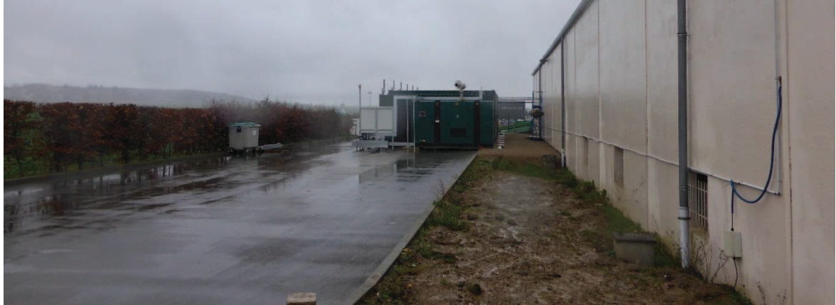
Vue générale plateforme depuis l'Est , 01/2018
