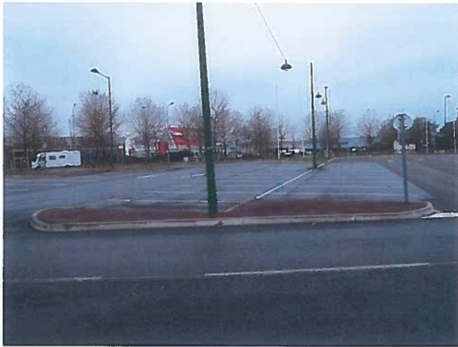
Prise de vue 3 : Vue du parking qui sera réaménagé et des alentours du site, de l'autre côté de la RD 40
