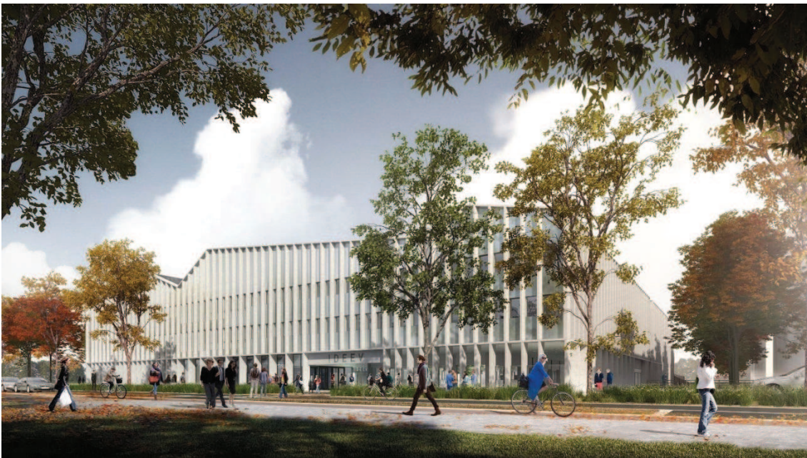
Vue depuis le Sud
