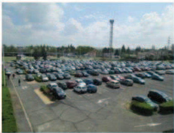
Photo 4 : vue parkings depuis passerelle
