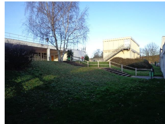
6. Vue sur les talus entre le bâtiment A et les ateliers
