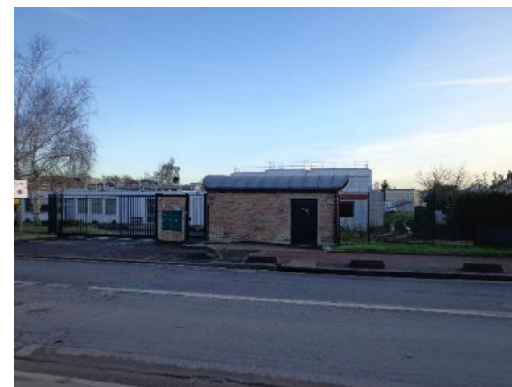
8. Vue sur l'entrée personnel / Logements (Rue Louis Vaninni)
