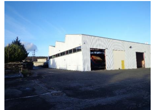
12. Vue sur les ateliers, bâtiment B
