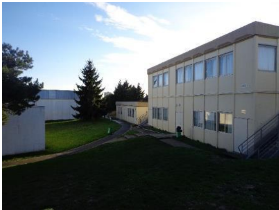
11. Vue sur les bâtiments démontables
